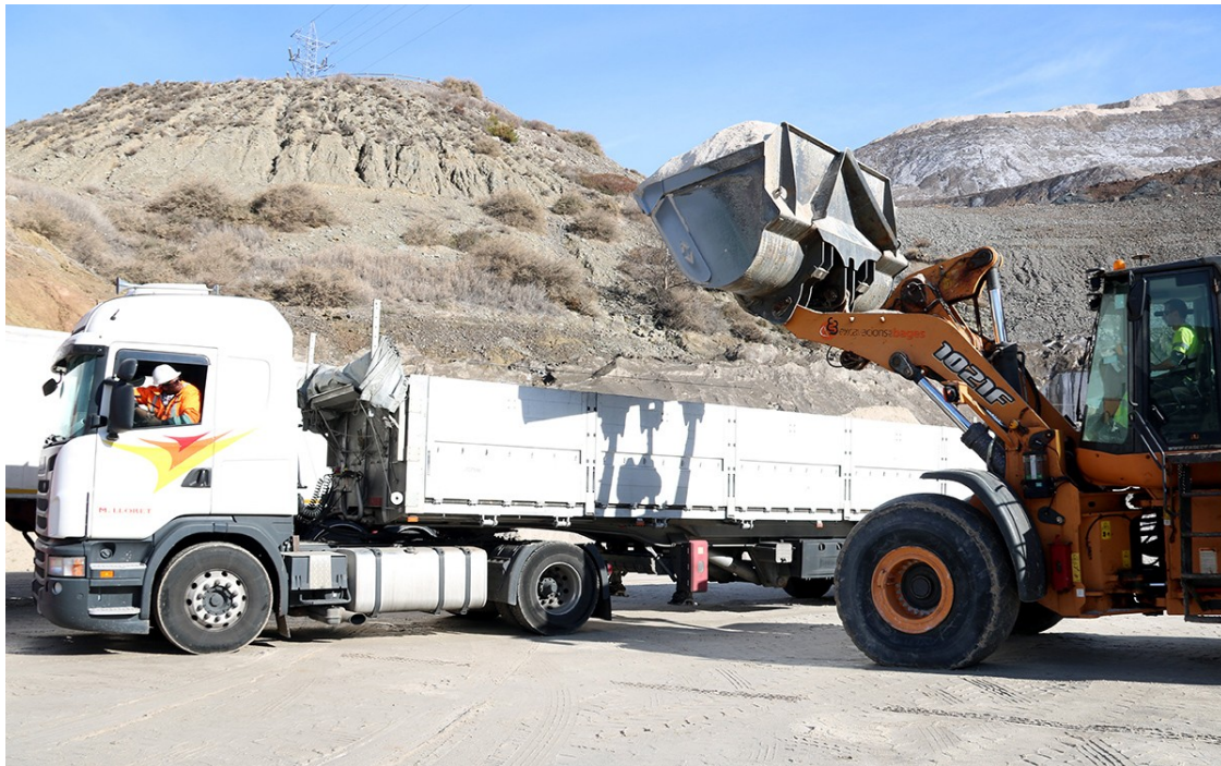
Una excavadora carregant la sal a un camió a la planta d'ICL Iberia de Súria | Mar Martí
