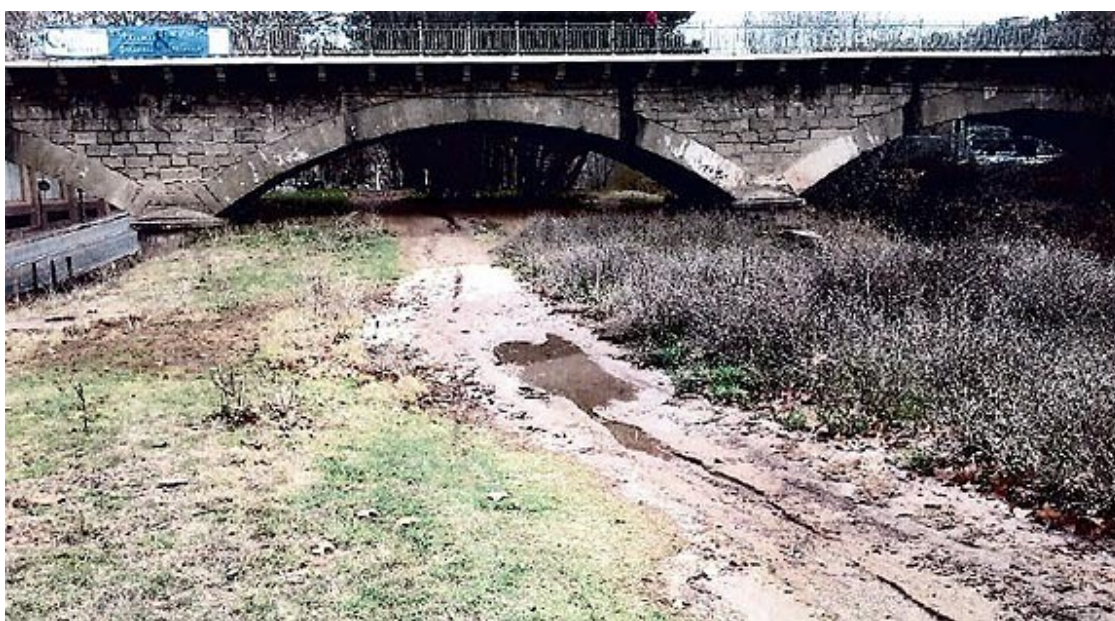
Fuita de salmorra visible al sòl d'un tram del Passeig del Riu. Foto: Meandre
