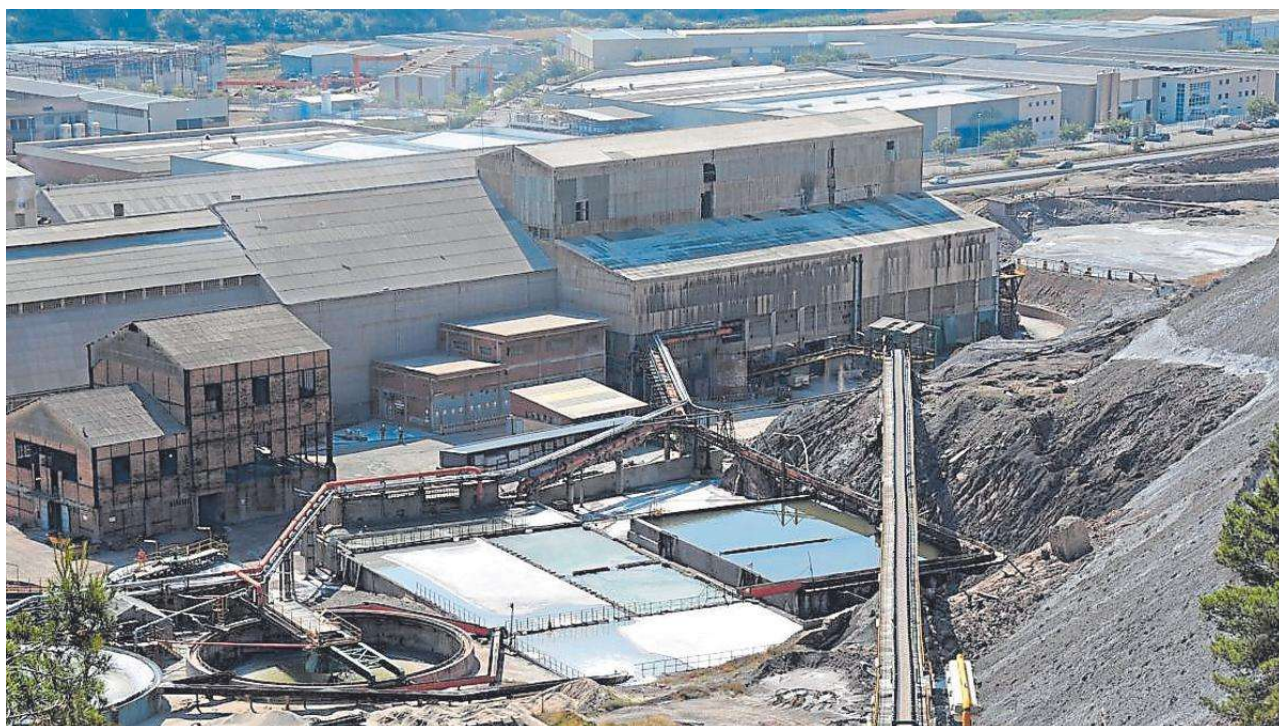
Instal·lacions de la fàbrica de la cinta transportadora de la mina de Sallent / ARXIU / SALVADOR REDÓ
