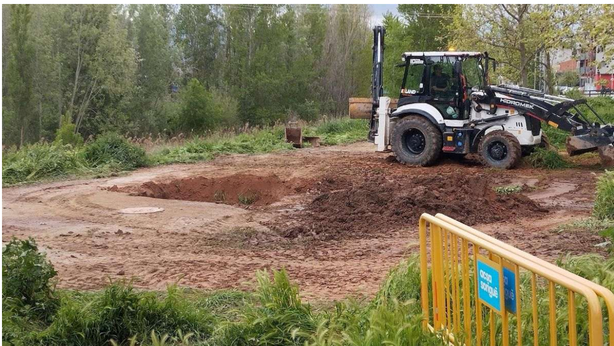
Reparació d'un vessament del col·lector a Sant Joan, l'abril passat / ARXIU/DAVID BRICOLLÉ
