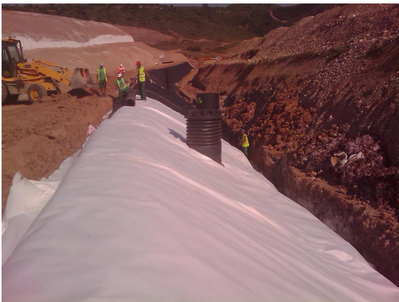
Treballs de cobriment del dipòsit de Vilaforns, l'any 2010 / ARXIU/GS
