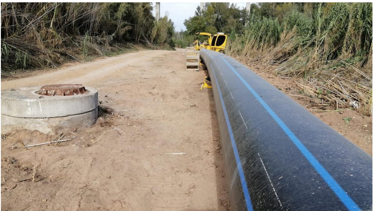
Construcció del col·lector de salmorres, que en el ramal del Cardener tindrà en paral·lel la canonada d'impulsió ARXIU/DAVID BRICOLLÉ
