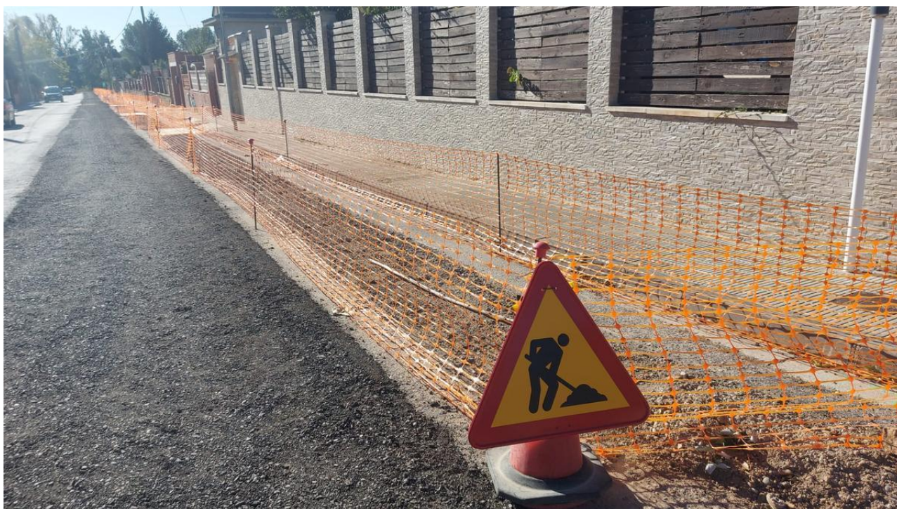
Rasa per on s'ha fet passar la canonada al nucli de la Torre del Breny de Castellgalí. PAU BRUNET
