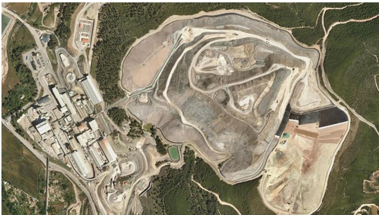
Vista aèria del dipòsit del Fusteret de Súrria ICC
