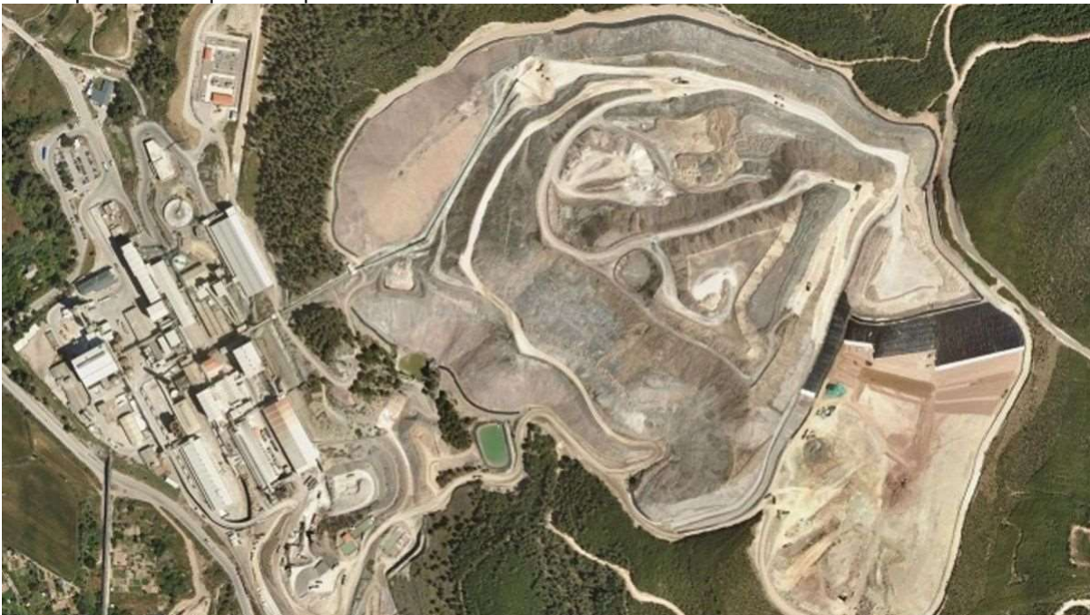
Vista aèria del runam de Vilafruns de Súria, que disposarà de més espai cap al sud | ARXIU/ICGC
