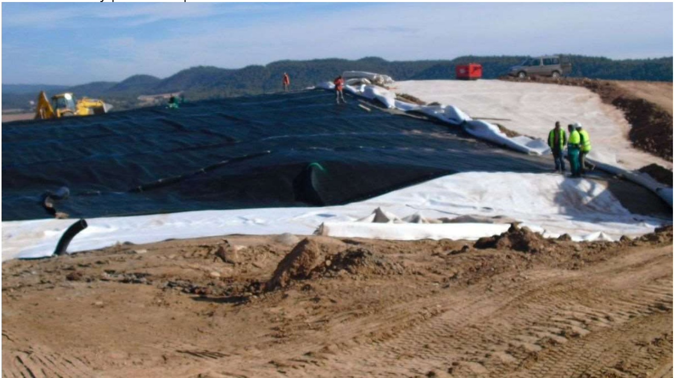
El runam de Vilafruns, durant els treballs per aïllar-lo amb polietilè | ARXIU/S.R.
