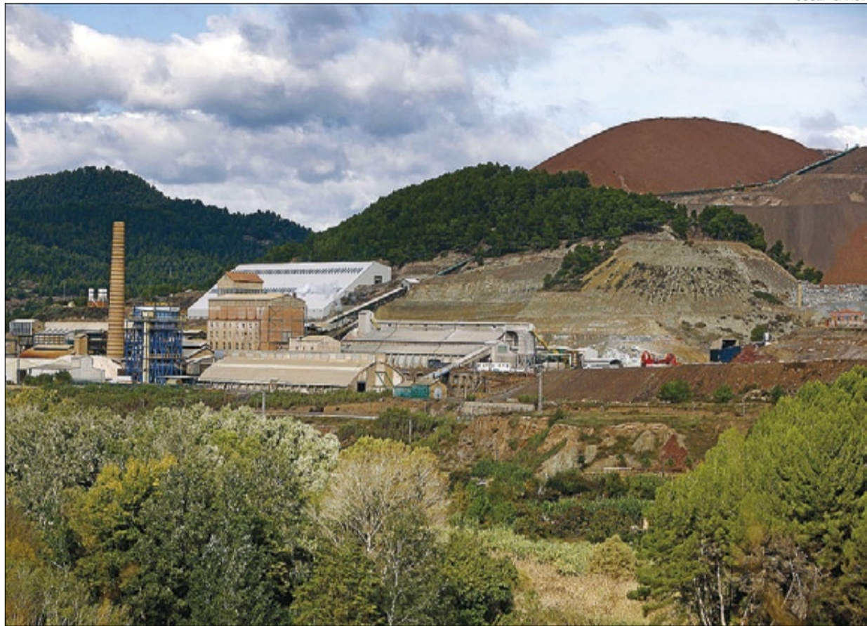
▶▶ L'explotació ▶ Aspecte exterior de les mines d'Iberpotash a Súria.
