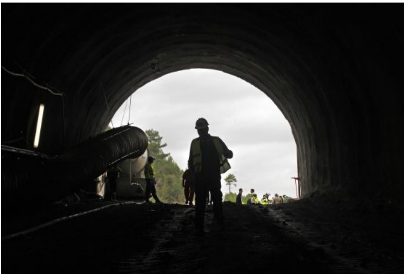
Vista exterior del nuevo túnel de extracción. / SUSANNA SÁEZ
