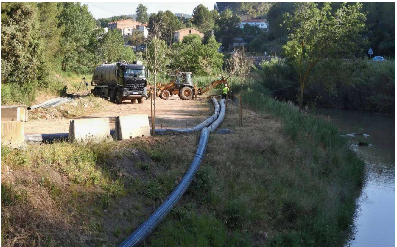
Operaris i maquinària operant en el col·lector de salmorres a l'altura de la Pobla, a Súria - MONTSALAT
