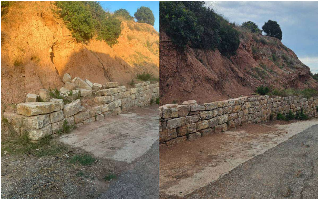
El mur del cementiri de Callús abans i després de la reparació – BOICOT ICL
