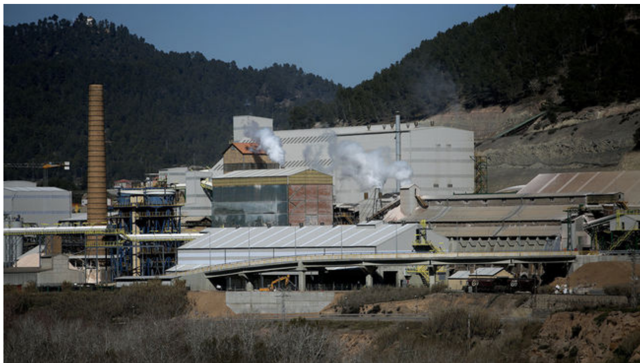
Instal·lacions industrials d'Iberpostash, propietat d'ICL, a Súria / PERE TORDERA
