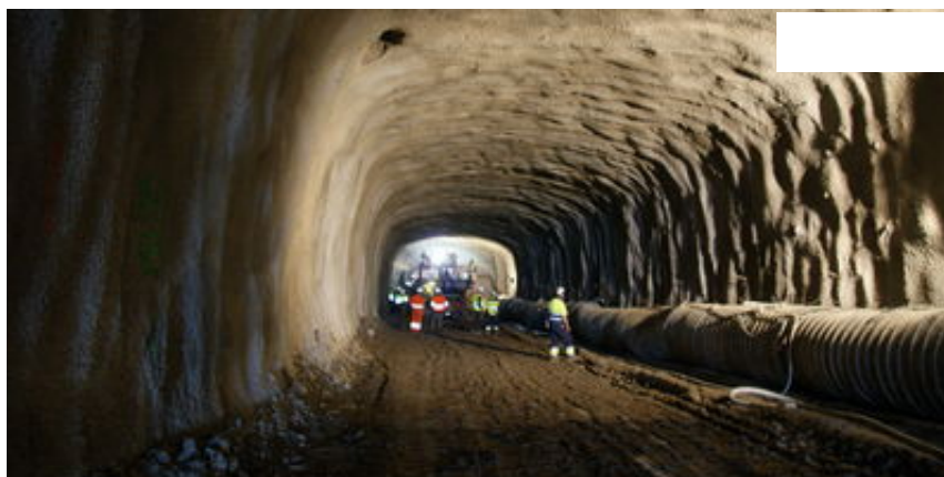
Iberpotash ja ha excavat els primers 200 metres del nou túnel a Síria
