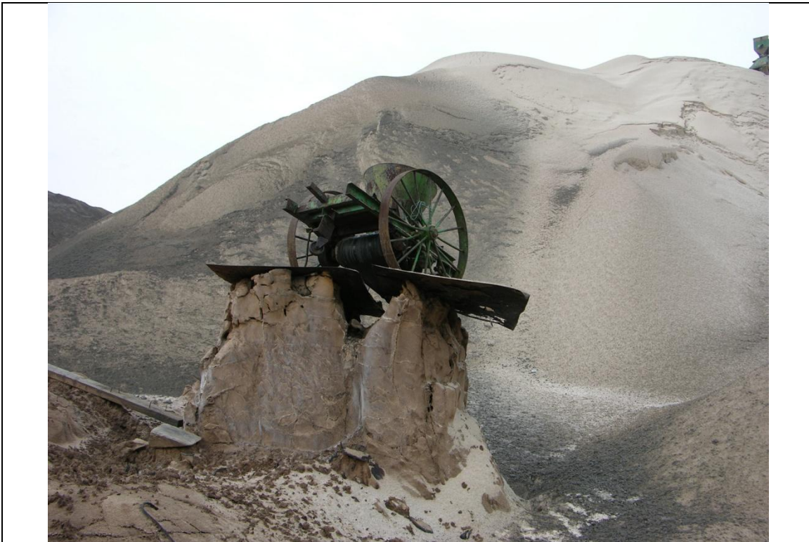
Imatge d'un sector del runam de Sùria on durant anys no s'hi abocà. La màquina llançadora abandonada marca un descens del nivell del runam de l'ordre dels 2 metres, a causa de la dissolució de la sal per l'aigua de pluja i de la captada de l'aire per higroscòpia. Actualment tot ha quedat sepultat sota nous residus. (foto 08.12.2005)
