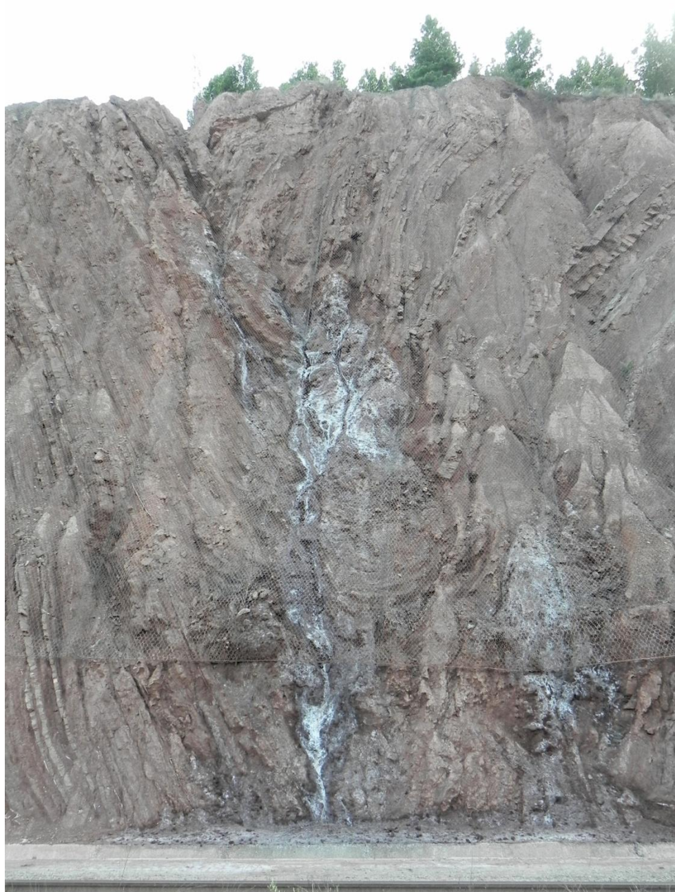
Surgència salada a la falla del Guix al pas de la via del FGC (Sallent)
